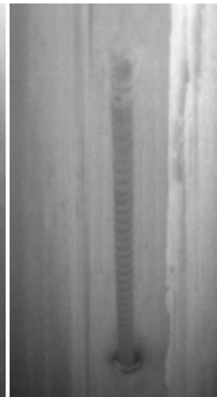
● Lanzas de soplador de hollín (SF) desalineadas
